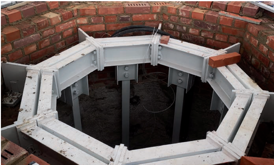
Auflagekonstruktion bei ca. 37 m
