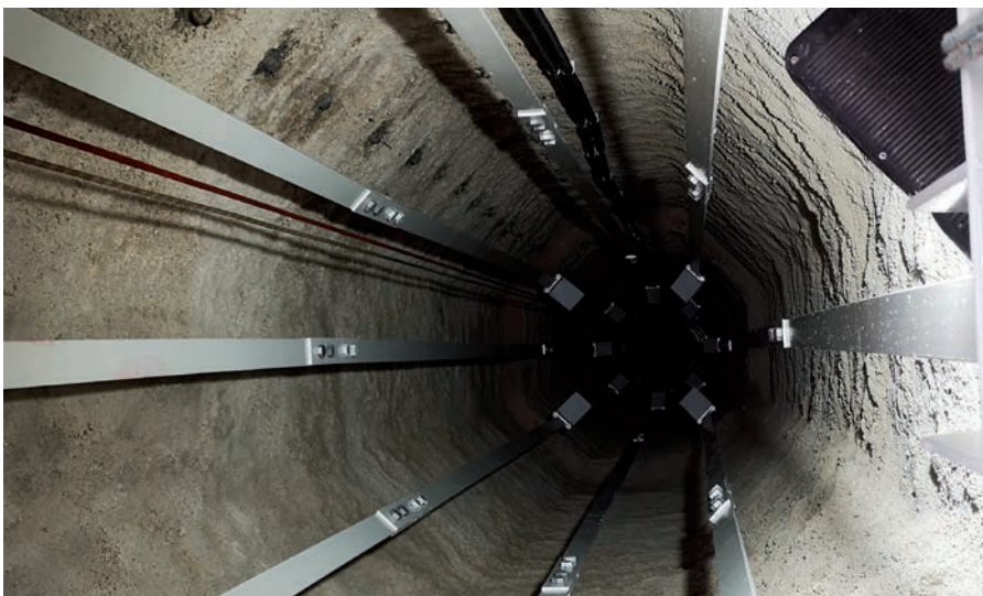
Blick in das Innere des Schornsteins mit Zugstangen
