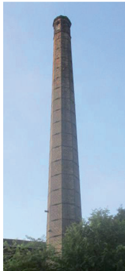
Mauerwerksschornstein 8-eckig ca. 50 m hoch
