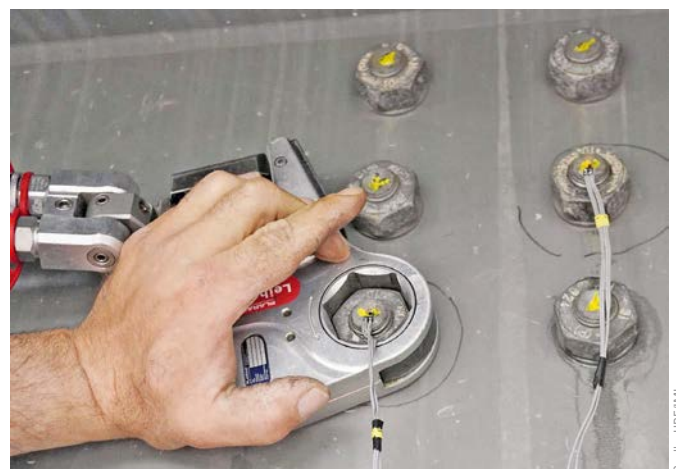
Bild 6 Lösen der mit DMS versehenen HV-Schraubenverbindungen Loosening of the HV bolted connections with strain gauges
