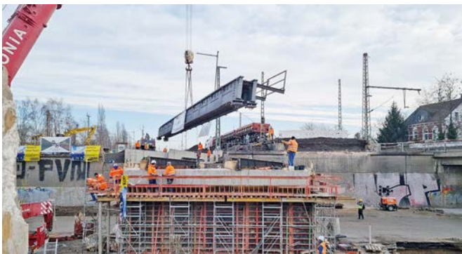
Bild 11 Einhub des ersten Zwillingsträgerpaars der Zwillingsträgerhilfsbrücke Stroke-in of the first pair of twin girders of the auxiliary bridge
