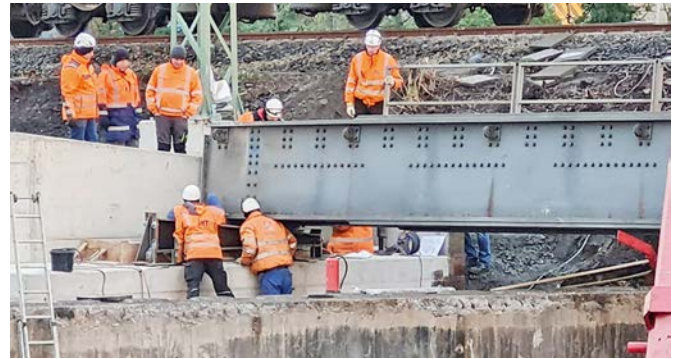
Bild 12 Ablegen des ersten Zwillingsträgerpaars auf der Hilfstraverse an der Widerlagerachse Placing the first pair of twin girders on the auxiliary crosshead at the abutment axis
