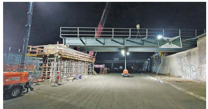
Bild 13 Final ausgerichtete Zwillingsträgerhilfsbrücke Final aligned twin girder auxiliary bridge
