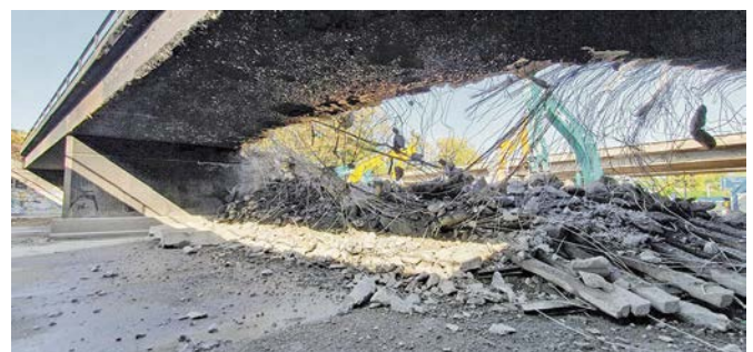
Bild 9 Abbruch des brandgeschädigten Brückenüberbaus Demolition of the fire-damaged bridge superstructure
