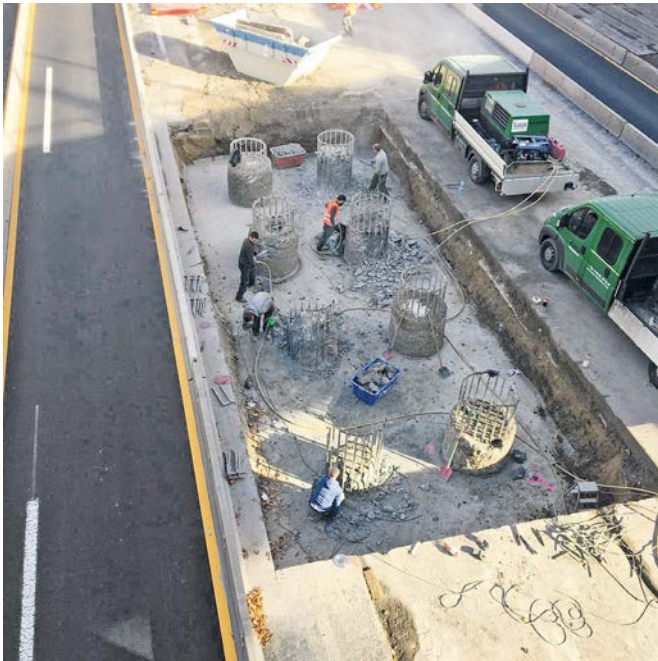
Bild 10 Draufsicht auf die Bohrpfähle der Pfahlkopfplatte des Mittelpfeilers Top view of the bored piles of the pile cap of the central pier
